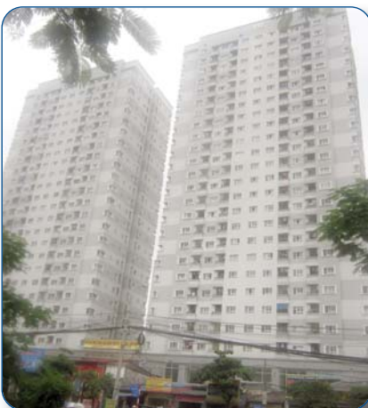
Công trình Viện Bông Địa chỉ: Hà Nội
