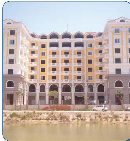
Công trình khách sạn Hoàng Gia Địa chỉ: Quảng Nam
