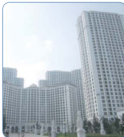
Công trình tòa nhà Royal City Địa chỉ: Nguyễn Trãi - Hà Nội
