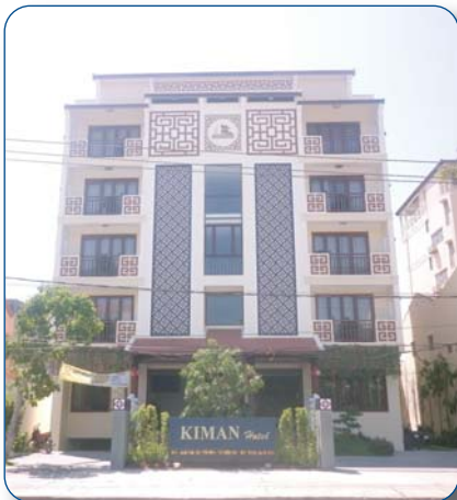
Công trình khách sạn Kim An Địa chỉ: Quảng Nam
